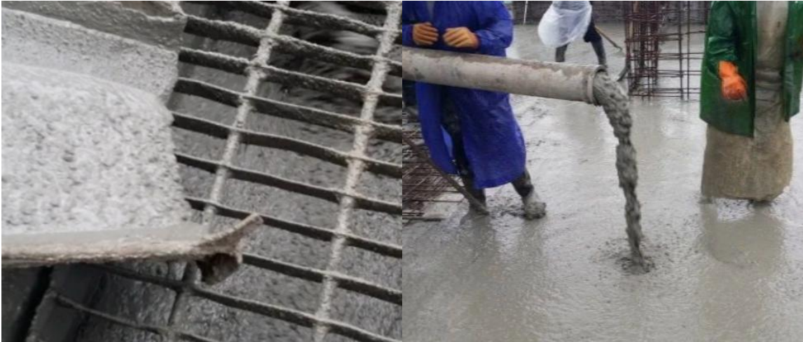
自密实混凝土入泵状态
