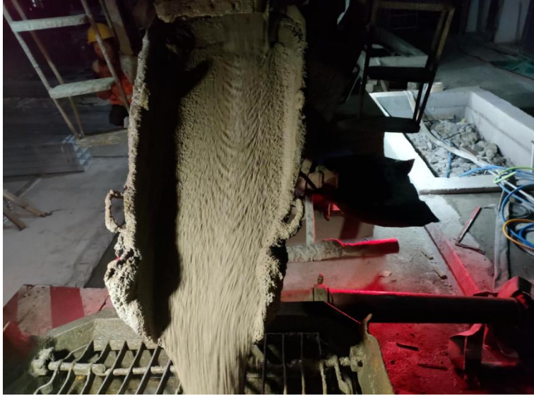
贵阳九悦综合体项目C30自密实混凝土
